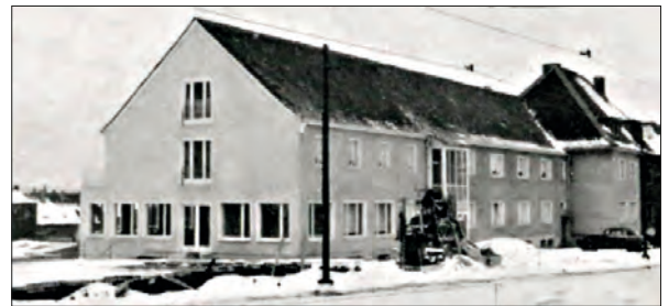
Das damalige Wohnheim an der Kampstraße
